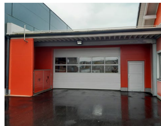
Zubau Rüsthaus Pitschgau-Haselbach
