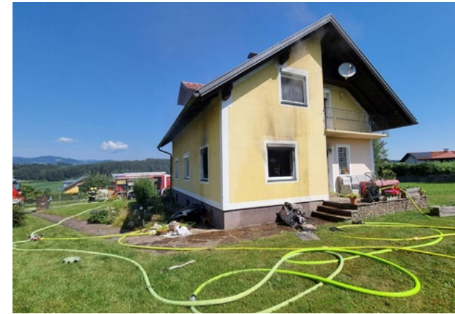
29. Juni 2024: Brand eines Einfamilienhauses in Hörnsdorf. Im Einsatz: Feuerwehren Hörnsdorf, Eibiswald, Pitschgau-Haselbach, Lateindorf, Wildbach (ELF) und Magna Lannach (WLF-ATS).
