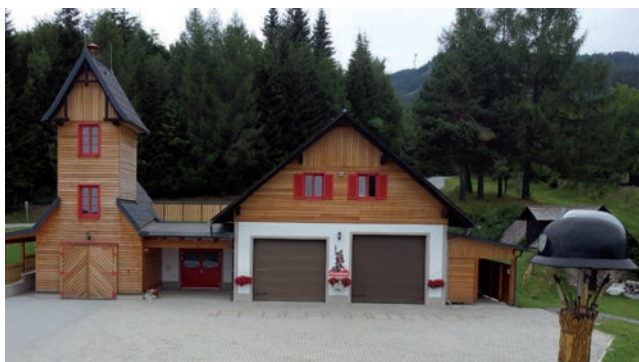
Sanierung Rüsthaus Glashütten
