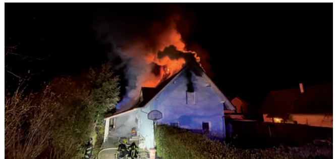
20. November 2022: Brand eines Wohnhauses in Stainz: Durch den massiven Löscheinsatz konnte ein Übergreifen auf die umliegenden Wohnhäuser und ein noch größerer Schaden verhindert werden. Im Einsatz: 8 Feuerwehren.
