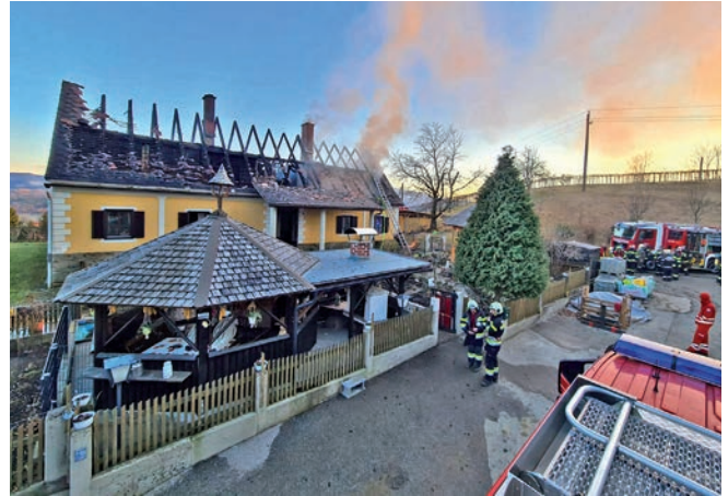
08. März 2022: 11 Feuerwehren rückten zu einem Wohnhausbrand in Pitschgau aus. Das Obergeschoss des Hauses wurde durch den Brand schwer in Mitleidenschaft gezogen, Menschen kamen glücklicherweise nicht zu Schaden.
