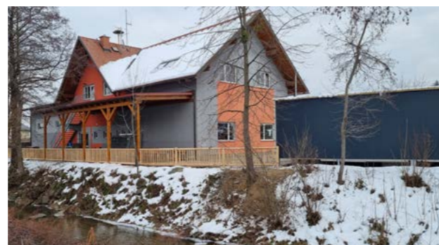
Halle/Überdachung Feuerweh Hörmsdorf
