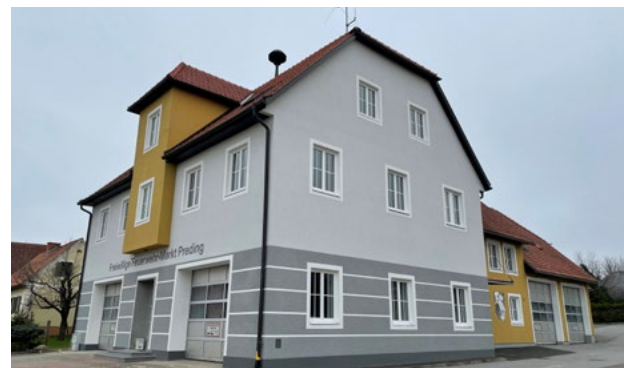
Sanierung Rüsthaus Preding
