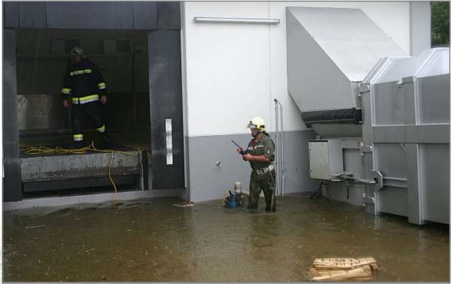
Auspumparbeiten in Stainz
