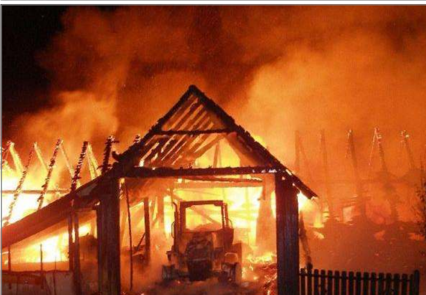
Wirtschaftsgebäudebrand in Soboth am 29.10.2009, im Einsatz: FF Soboth, FF St. Oswald o.E. und FF Eibiswald, 2 Verletzte
