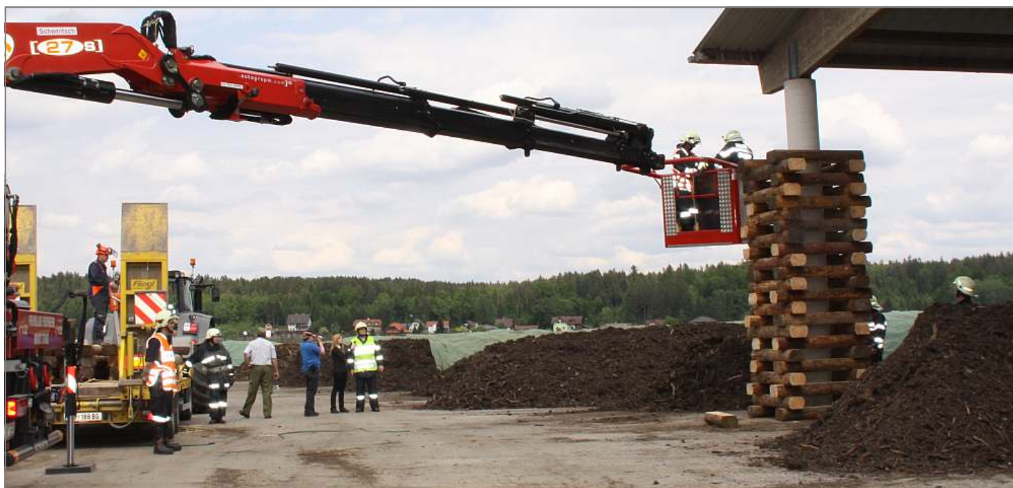
Die Stützen einer Halle werden mit Holz gesichert um einen Einsturz zu verhindern
