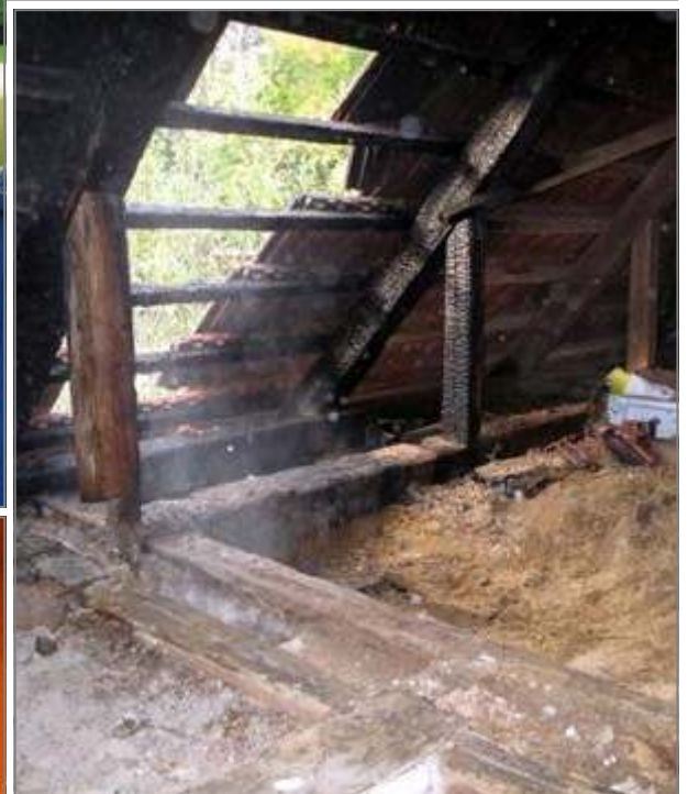
Zwischendeckenbrand in Bad Gams am 21.10.2009, im Einsatz: FF Bad Gams, FF Stainz und FF Gr. St. Florian
