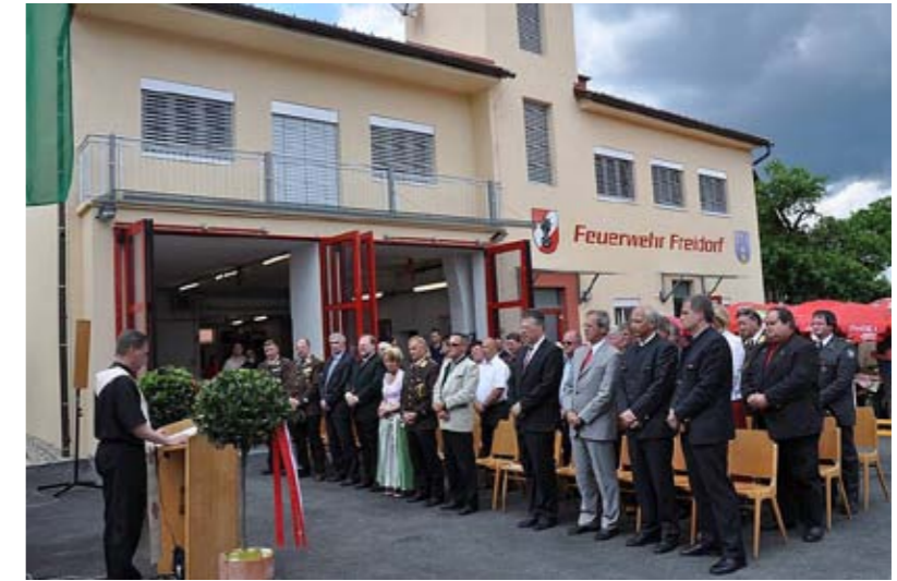
Das 1959 erbaute Rüsthaus Freidorf wurde einem Umbau unterzogen.
