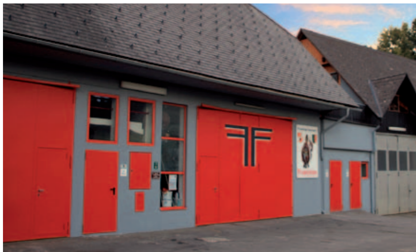
Die Feuerwehr Trahütten konnte ihr Rüsthaus umbauen.
