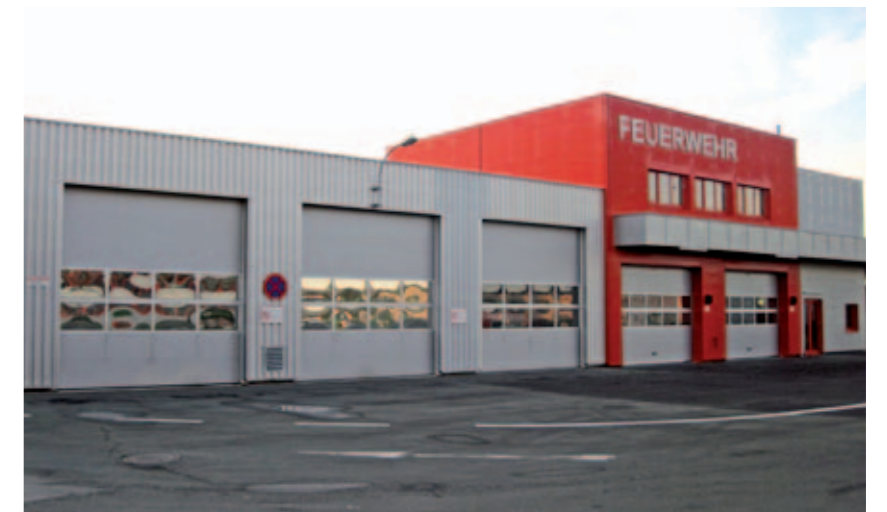
Neues Rüsthaus für die Btf Magna Lannach: 4 Monate Bauzeit.
